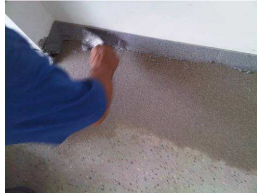
Einbau der Hohlkehle
