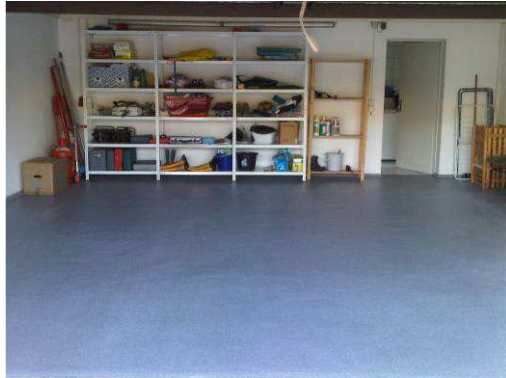
Der fertige Garagenboden.
