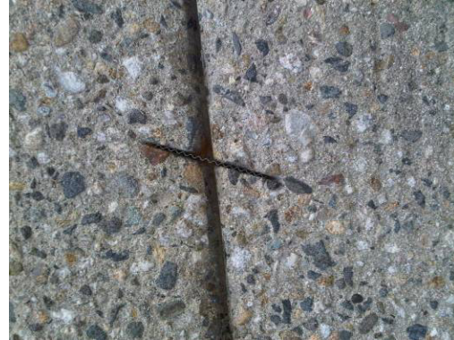
Fugen werden verklammert
