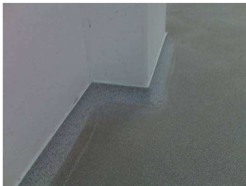
Der Anschluss zur Wand mit Membrane
