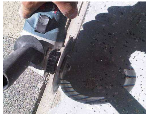
Anschlüsse werden eingeschnitten
