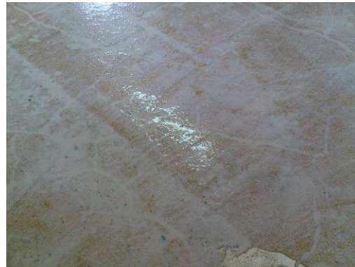
Risse werden mit Plastifloor® 510 verspachtel
