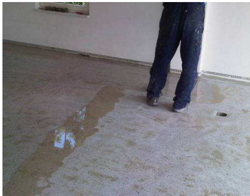
Grundierung mit Plastifloor® 112
