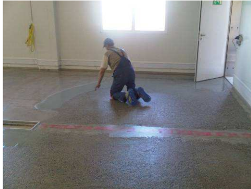
Verlegung der Membrane
