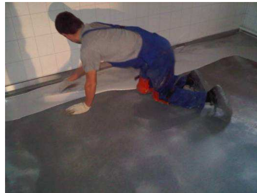
Verlegung der Beschichtung
