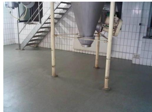
Plastifloor® ist ein thermoplastischer Werkstoff, Längenänderung der Materialien bei wechselnden Temperaturen werden leichter verkräftet, auch heruntergefallene Teile werden von diesem Boden leichter aufgefangen, da er schwingungsabsorbierend in mehreren Lagen aufgebaut wird. Plastifloor® ist rutschfest und leicht zu reinigen. Der Belag ist getestet nach dem LMBG und für gut befunden. Damit kann der Boden in einem Lebensmittel verarbeitenden Betrieb bedenkenlos eingebaut werden.
