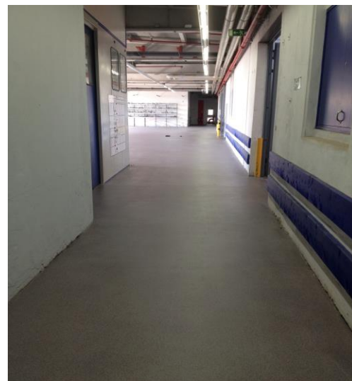
Deckbeschichtung versiegelt
