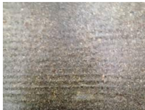
Der Untergrund wird porendicht verschlossen
