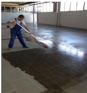
Grundierung mit Plastifloor® 112
