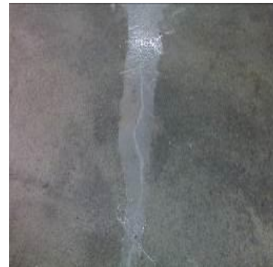
Risse werden verspachtelt
