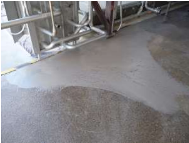
Unebenheiten werden mit Plastifloor® Mörtel geebnet.
