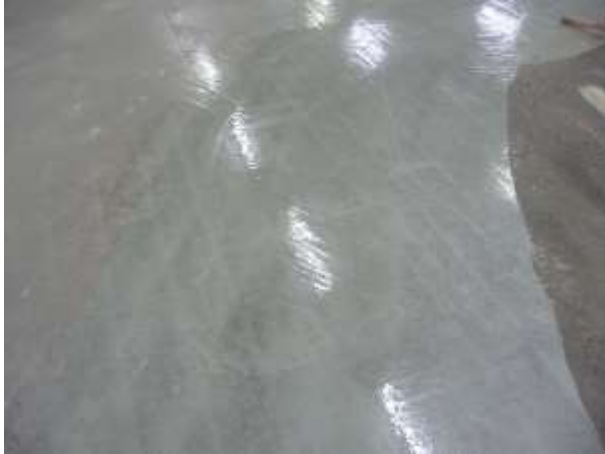
Einbau der Membrane aus Plastifloor 332/z
