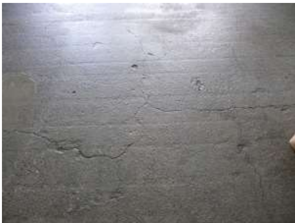
Plastifloor® 112 Grundierung auf Beton
