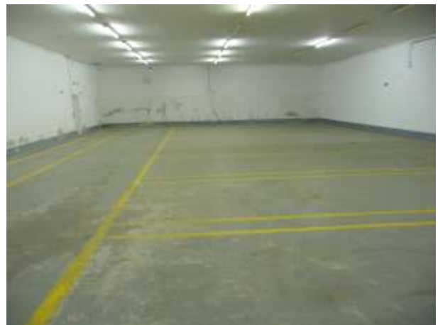
EP-Beschichtung platzt ab
