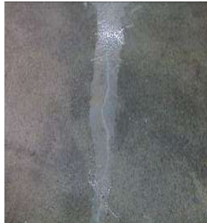
Risse werden verspachtelt
