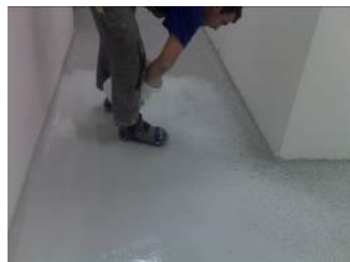
Deckbeschichtung abstreuen mit Farbchips
