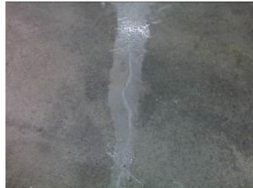
Risse werden mit Plastifloor® 510 + s/l filler vergossen
