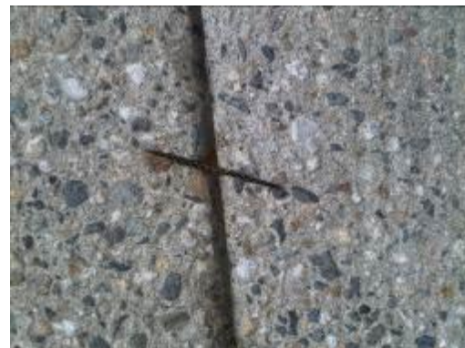
Fugen werden verklammert
