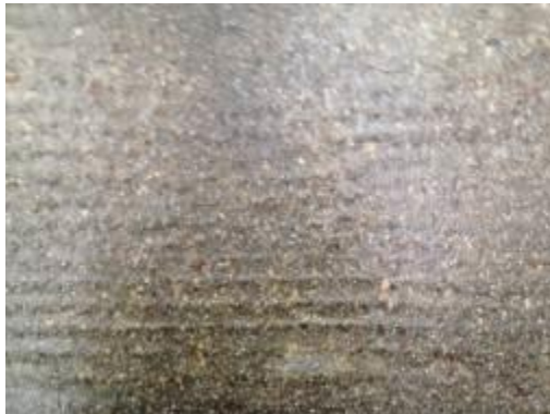
Grundierung mit Plastifloor® 112
