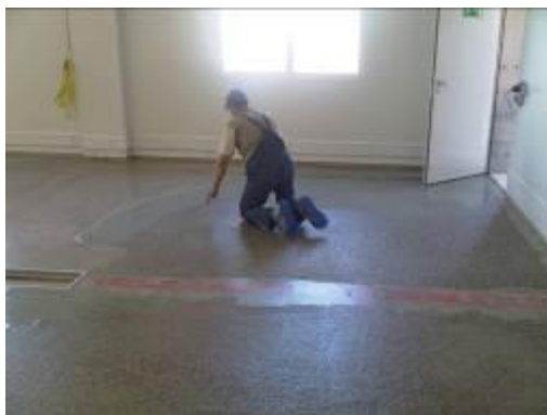
Verlegung der Membrane
