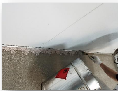
17. Verwenden Sie einen Spatel, um die Mischung gleichmäßig zu verteilen
