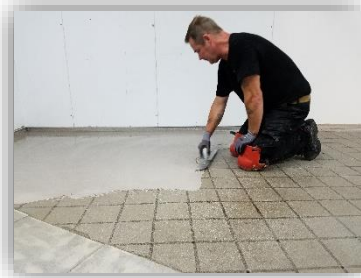
13. Membran Plastifloor® 332 auftragen
