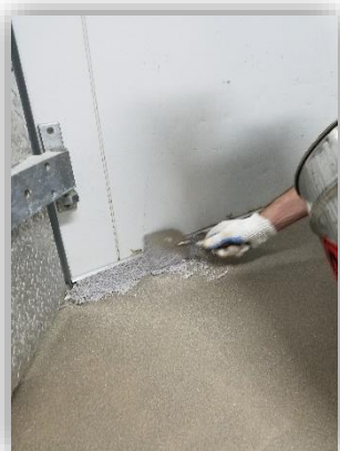
16. Vorgrundierter Untergrund und leicht ausgestrahlt
