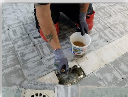
4. Grundierung der Löcher
