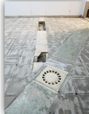
3. Untergrund bereit für die Grundierung
