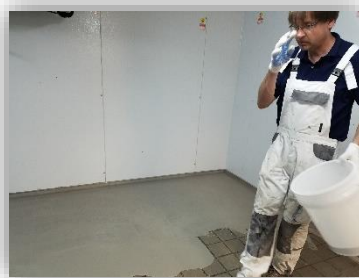
14. Abgestreut mit Sand 0,6-1,2 mm
