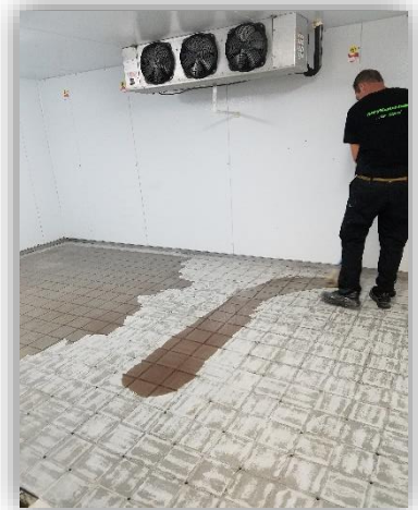
9. Grundierung der gesamten Fläche mit Walzenlammfell
