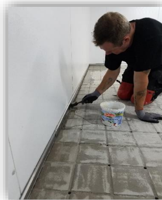
5. Grundierung der Hohlkehlen
