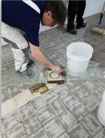
8. Grundieren der Details mit einem Pinsel
