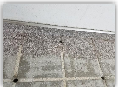
6. Abgestreute Hohlkehlen nach dem Grundieren
