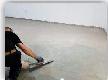
15. Mit schwedischer Kelle aufgetragen
