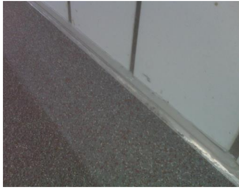
Fertige Hohlkehle mit Profil
