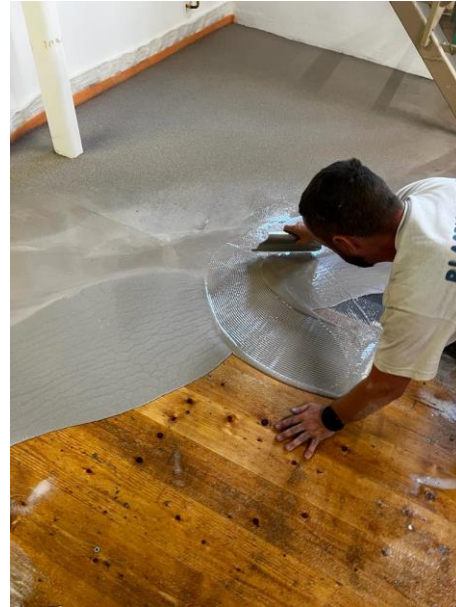
Die Plastifloor 332 Membrane wird verlegt
