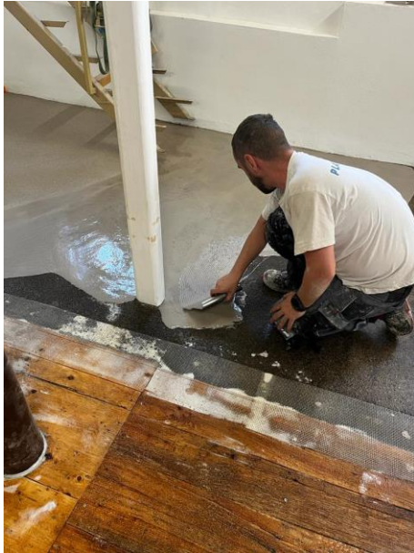
Übergänge werden mit Polyestergewebe verstärkt
