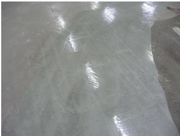
Einbau der Membrane aus Plastifloor 332
